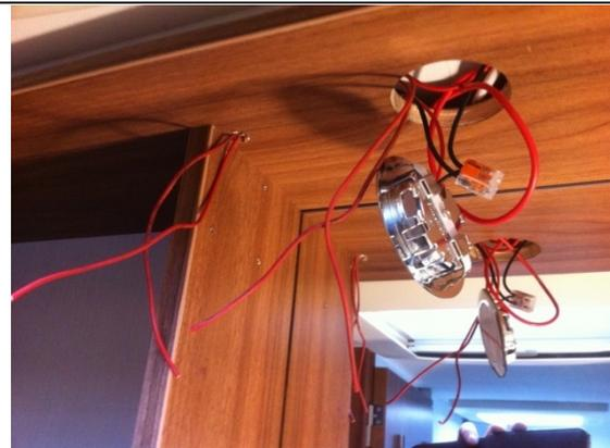
J'ai donc modifié l'alimentation de façon à pouvoir dorénavant allumer de l'intérieur avec la porte fermée. J'ai relié ensemble les deux fils de l'interrupteur d'origine, ce qui fait que les deux spots WC sont maintenant allumés.
