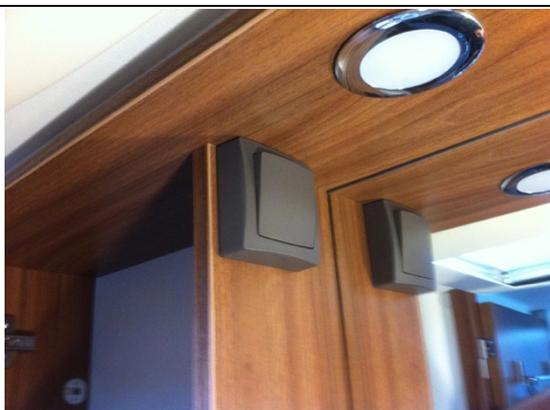
J'ai installé un nouveau bouton M/A de façon à cacher le trou de 10mm dans l'angle de la cloison. J'ai coupé le câble d'alimentation en courant électrique du spot et relié chaque extrémité de ce câble aux deux fils du nouveau bouton M/A.
